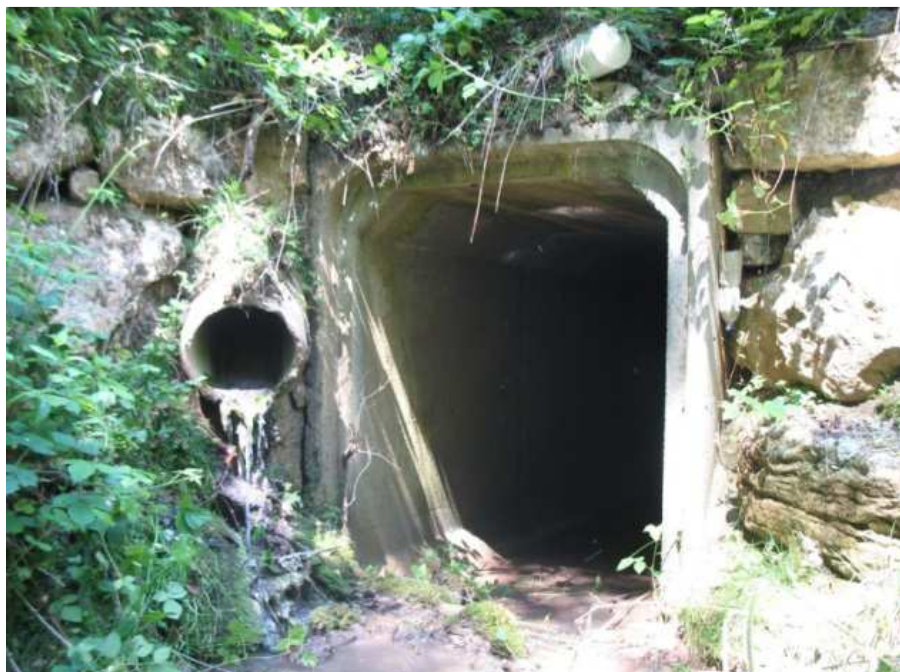
L'entrée du pont du Bellet, côté amont. -----
